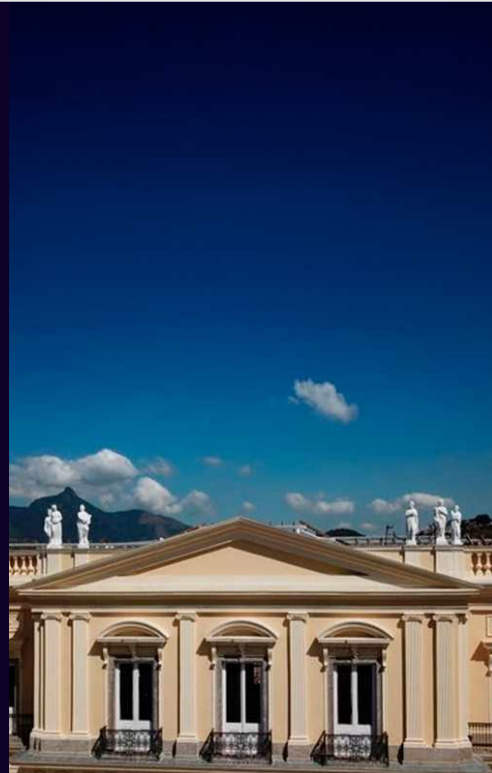
→ Fachada do Museu Nacional restaurada após incêndio causado por instalação elétrica improvisada.
